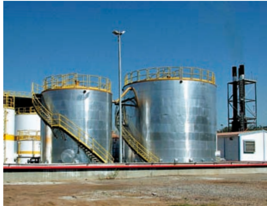
SÄHKÖÄ. Voimalaitos on El Salvadorille sen verran tärkeä sähköistysprojekti, että maan presidentti vieraili muutamaan otteeseen työmaalla.
